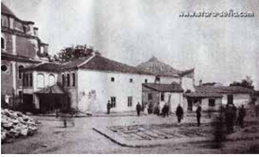
(Cami ve hamamın yıkılmadan önceki hali.)
