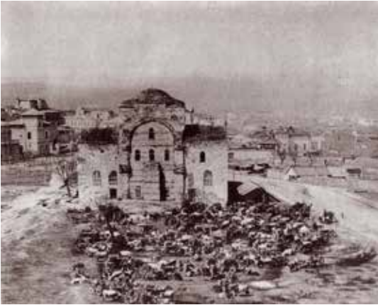
(Siyavuş Paşa Camii metruk haldeyken.)
