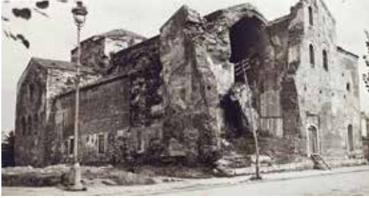
(Siyavuş Paşa Camii metruk haldeyken.)
