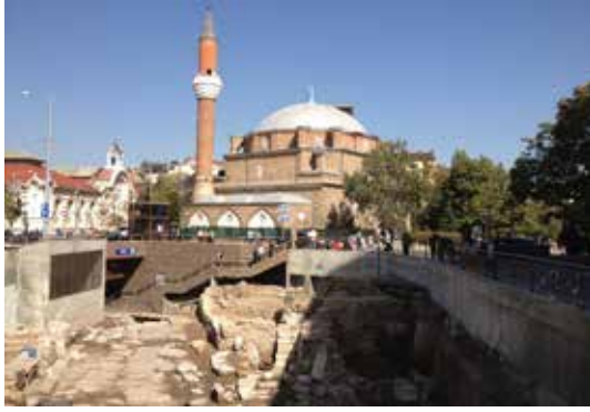
(Caminin hemen yanındaki metro inşaatı.)
