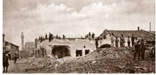
(Yıkım çalışmalarını gösteren eski bir resim.)
